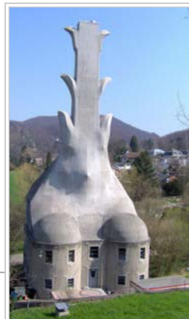
Das Heizhaus auf dem Goetheanum-Gelände
