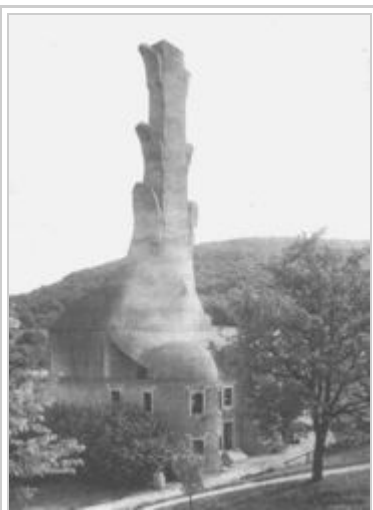
Das 1914 errichtete Heizhaus nach einer alten Ansicht
